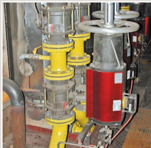
*Ballostar KHA avec actionneur pneumatique installé dans une sidérurgie sur du gaz de coke*
