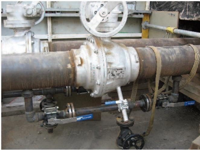
*Ballostar KHA installé en by-pass sur réseau de chauffage urbain*
