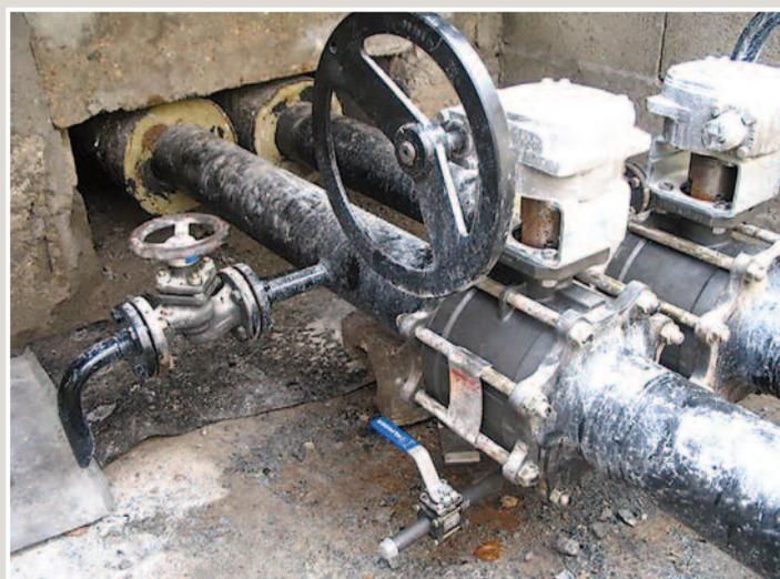
*Ballostar KHA avec robinet de contrôle d'étanchéité en ligne*
