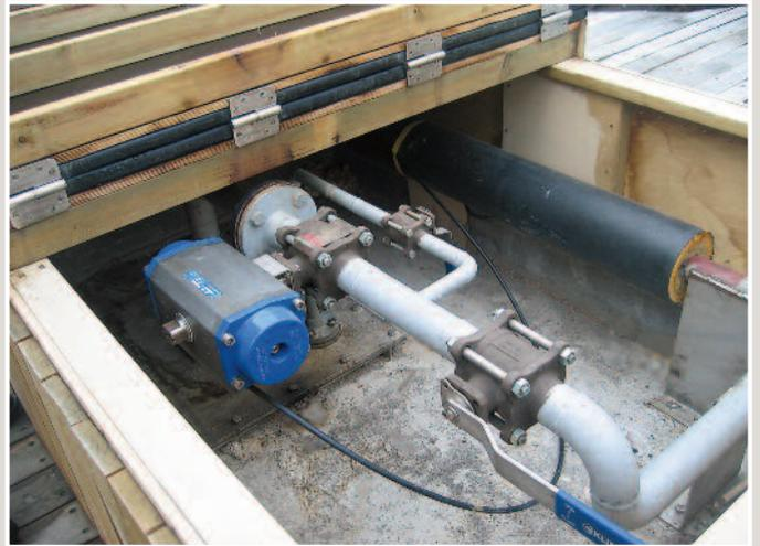
*Robinet Ballostar KHA installé sur un réseau d'eau chaude*
