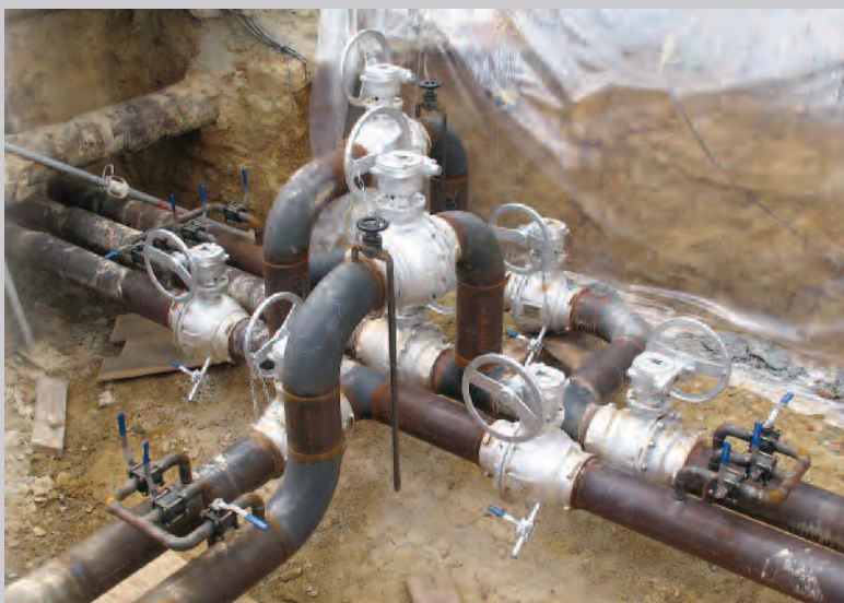
Chambre de vannes : Hôpital Ponchaillou Rennes
