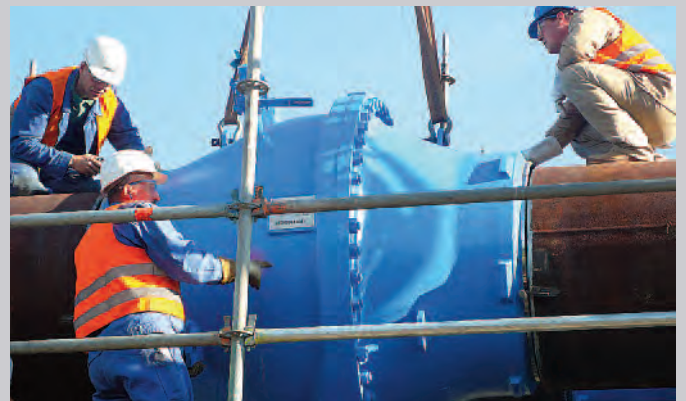
Mise en place de DN1000 sur le réseau de Berlin
