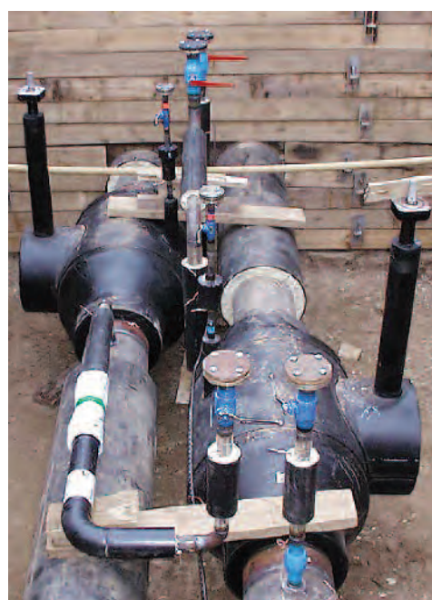
Robinet Ballostar tout soudé pré-isolé avec robinet de contrôle d'étanchéité en ligne également pré-isolé.
