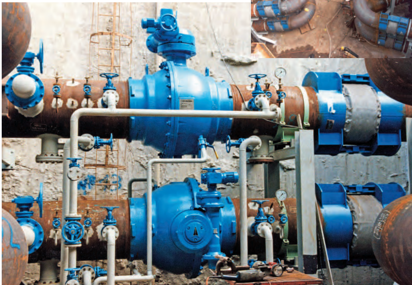
Réseau de chauffage urbain de Vienne (Autriche) en DN800
