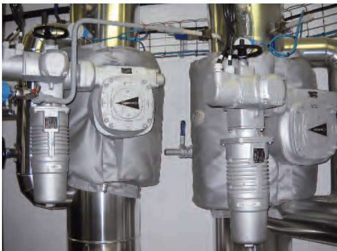
Robinet Ballostar avec motorisation type SA monophasé
