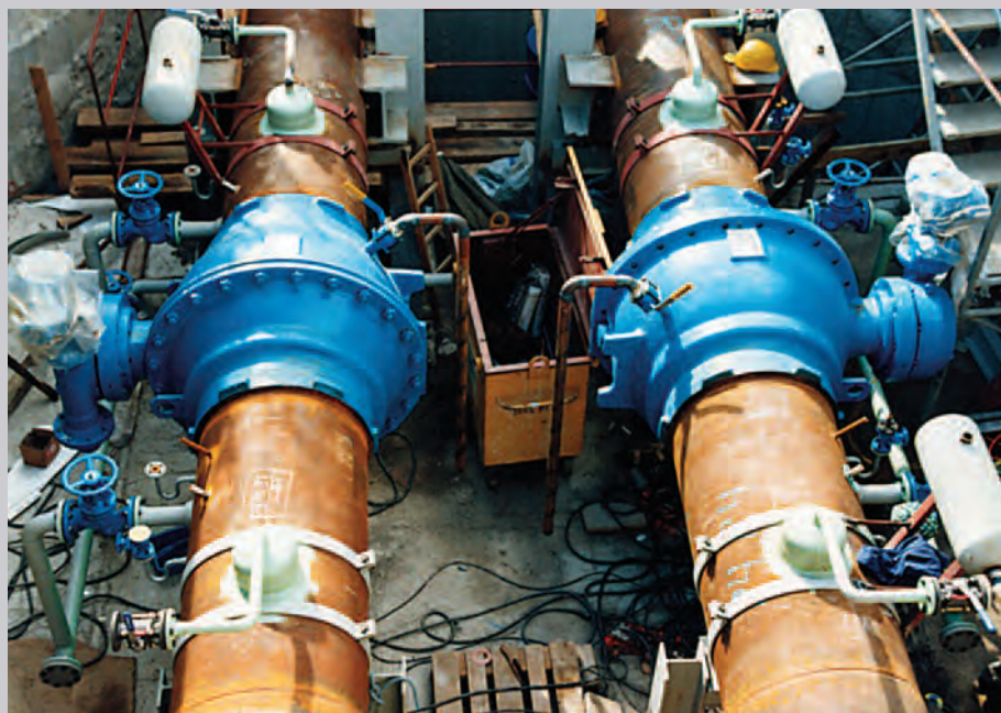
Réseau de chauffage urbain de Vienne (Autriche) aller-retour en Ballostar DN600
