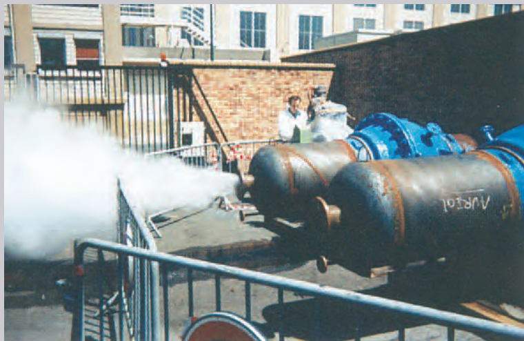
CPCU Paris : essais sur Ballostar DN 700 en vapeur eau surchauffée 235 °C 20 bar
