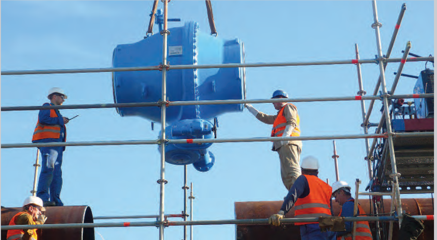
Mise en place de DN1000 sur le réseau de Berlin
