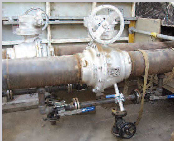
Chambre de vannes : réseau de chauffage urbain de Metz
