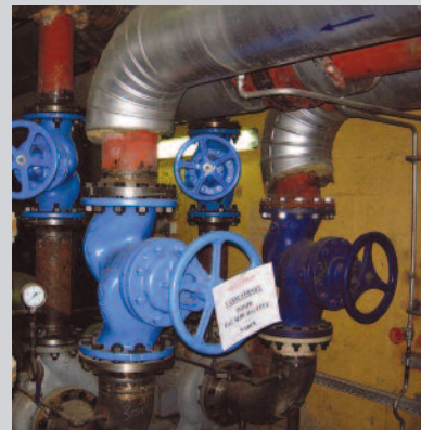
Chaudière eau surchauffée
