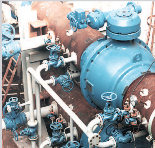
Réseau de chauffage urbain
