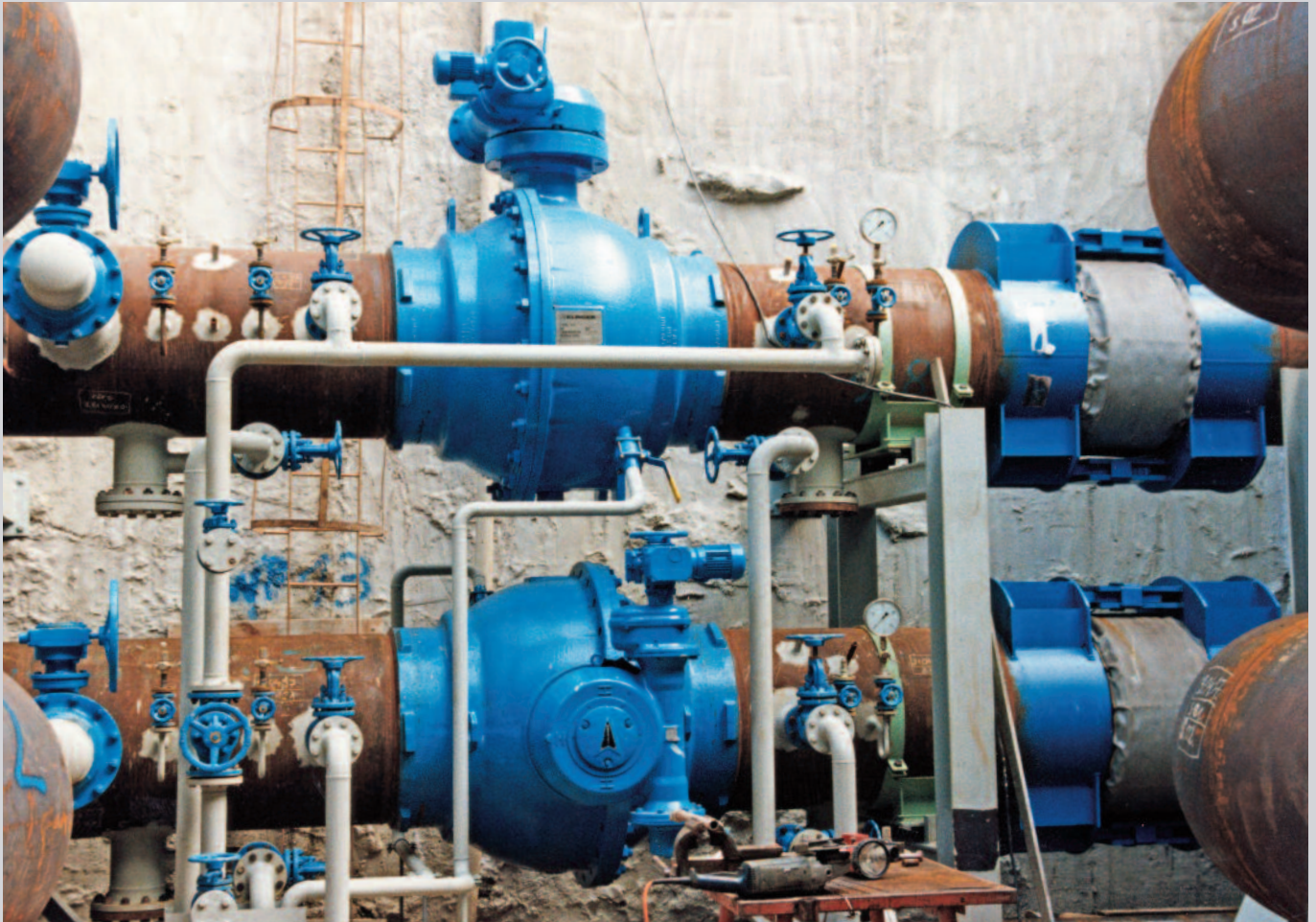
Réseau de chauffage urbain
